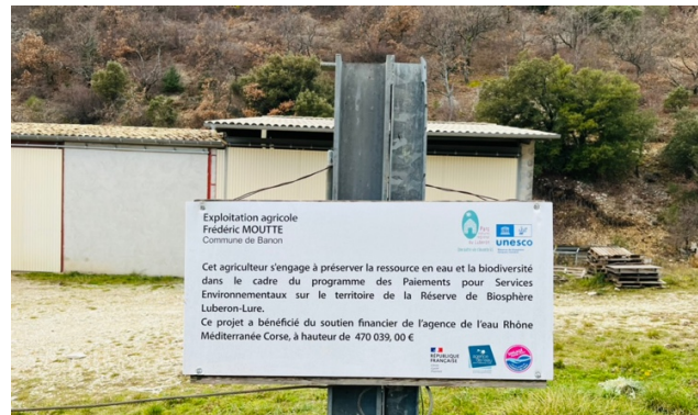
« Ma photo » du bâtiment depuis la clôture
