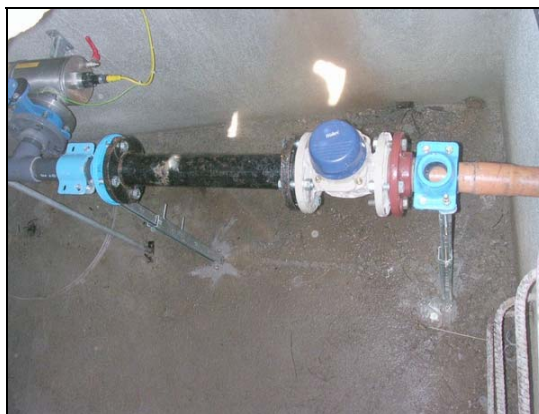
Compteur renouvelé et télétransmis source Peysson en DN 60 mm
