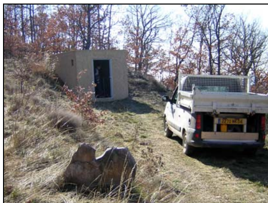
Réservoir des Agreniers
