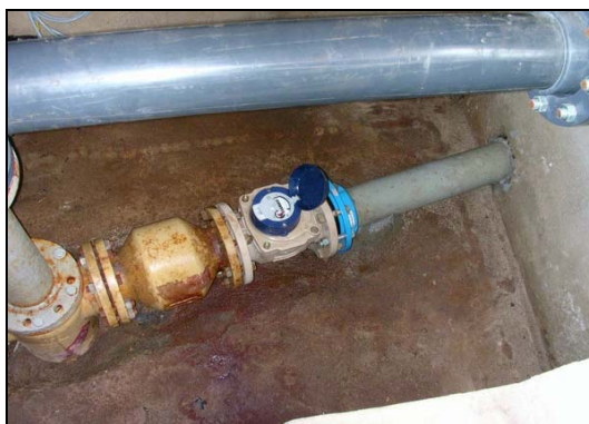
Compteur renouvelé et télétransmis source Peysson en DN 60 mm
