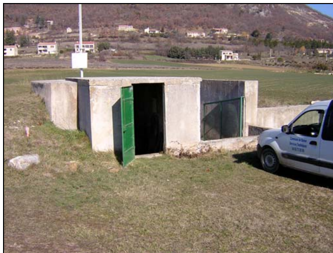
Ancienne station de pompage
