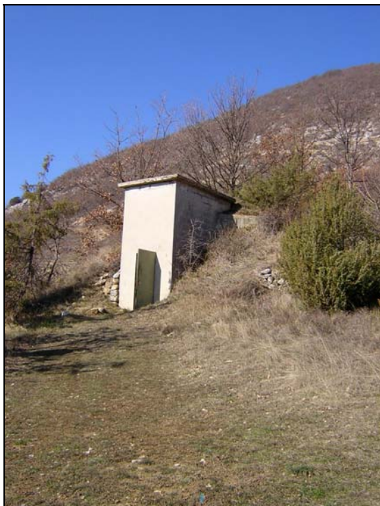
Réservoir St Roch
