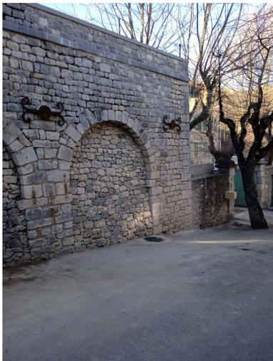
La voûte côté rue a été démontée, le mur côté presbytère a été lui aussi démonté entre deux contreforts, le sol sous la terrasse a été décaissé sur plus de 6 mètres de hauteur. Le drainage a été sérieusement construit, l'angle a été renforcé, puis la voûte et le mur ont été remontés, l'arase refaite. Bref, on n'y voit que du feu et on ne se doute pas que les murs viennent d'être réparés. Félicitations !
